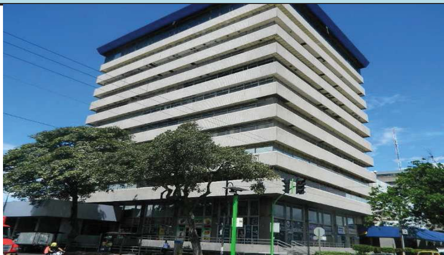
VISTA FRONTAL DEL EDIFICIO, CONDOMINIO CENTRO COL
