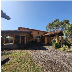
VISTA GENERAL DE VIVIENDA
